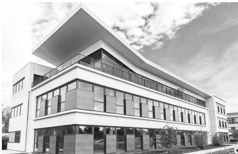
Magnisense laboratoire de R&D « Le Campus » à Dardilly (69) : vue extérieure – 1 er étage du bâtiment
